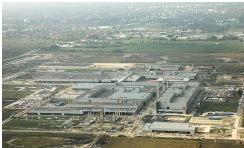
Az épülő Mercedes-üzem Construction site of the new Mercedes factory
